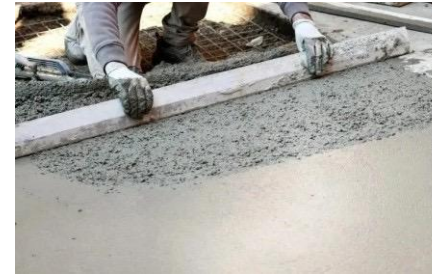
Ilustrasi pekerjaan rabat beton
