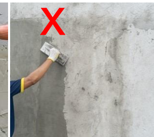
Proses perataan pada substrat
