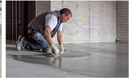
Aplikasi lantai kerja (Floor screed)
