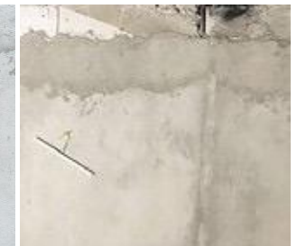
Dinding setelah diplester (tanpa di aci)
